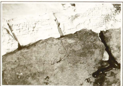
Figura 12. Los materiales de restauración (yeso), sobrepasan la malla de retención.
