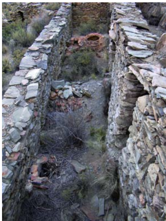
Figura 11. Fundiciones 2. Se observan los tres hornos de reverbero en el interior del recinto.
